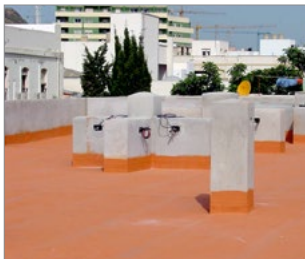
Hiszpania: budynek mieszkalny w miejscowości Vera
