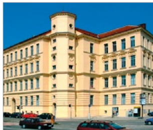
Czechy: Brno, budynek administracyjny
