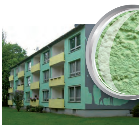
pomalowane ClimateCoating® ThermoProtect
