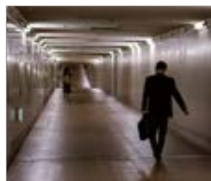
Oświetlanie przejść podziemnych
